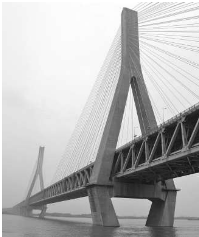
Рис. 3. Мост Тяньсинчжоу (кит. 武汉天兴洲长江大桥) — второй по длине основного пролёта 504 м автомобильно-железнодорожный мост вантовой конструкции в мире.
