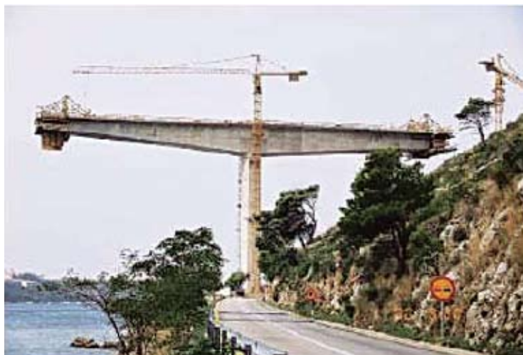
Рис. 1.8. Виадук подхода моста на стадии строительства
