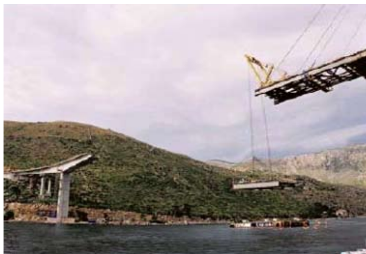
Рис. 1.10. Подъем стальной секции
