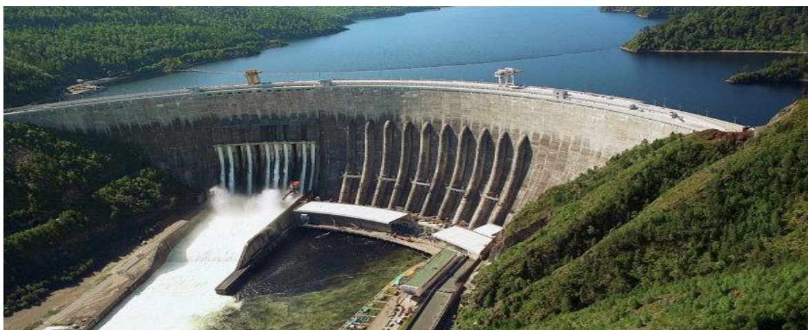
Рис.1. Общий вид плотины Саяно-Шушенской ГЭС
